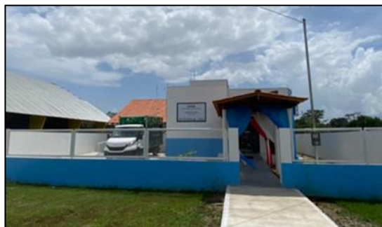
Foto 34: Fachada do Prédio do CRAS de CHAVES.
