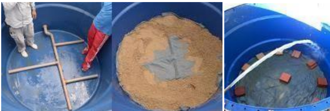
Figura 13: Exemplo de filtro lento de areia construído com caixa de 5.000 litros.
